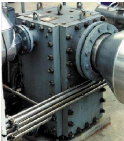
Figura 8- Compabloc instalado em planta na Escandinávia
