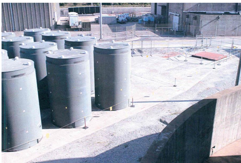
Figura 2: Módulos de Armazenamento a seco de ECIs na Usina Nuclear de Vogtle. [1]
