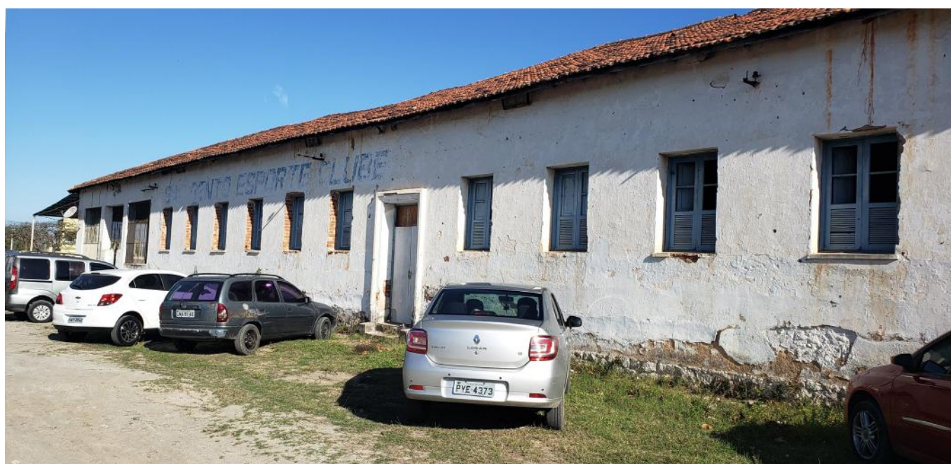
Aproximação parte central da fachada frontal da antiga Casa de Farinha. É possível ver sua fundação em pedra e as esquadrias originais. (Fonte autoral)
