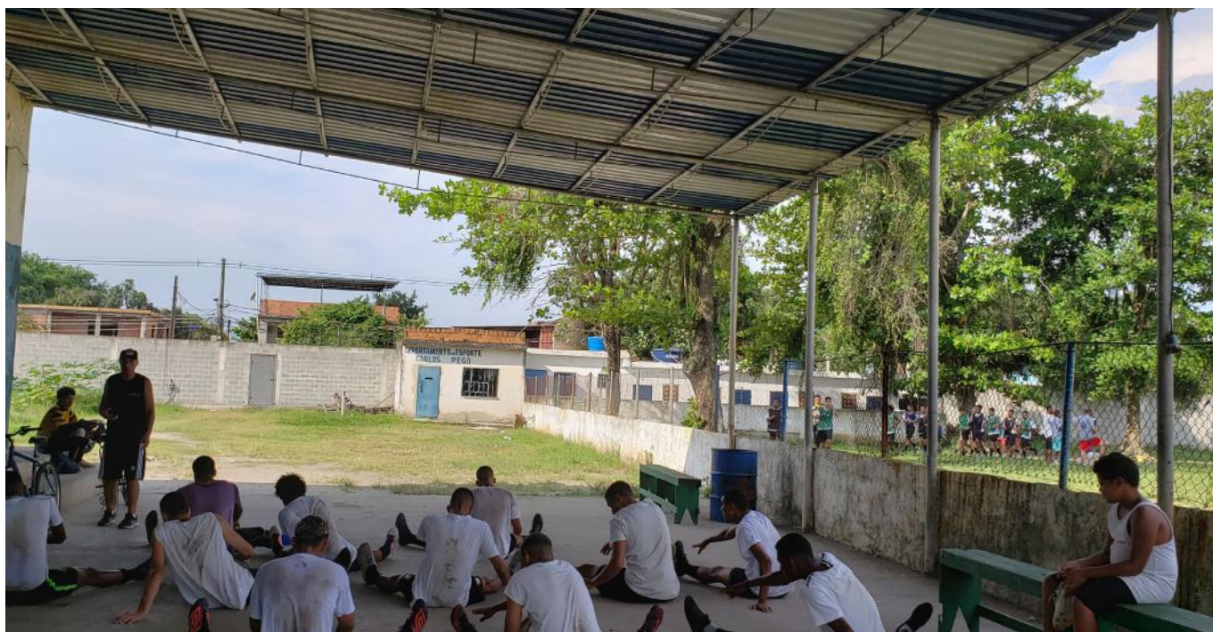
Fachada lateral esquerda da antiga Casa de Farinha. A cobertura é muito utilizada pelo público que assiste aos jogos, pelos consumidores da cantina assim como pelos jogadores para aulas e aquecimento. (Fonte autoral)
