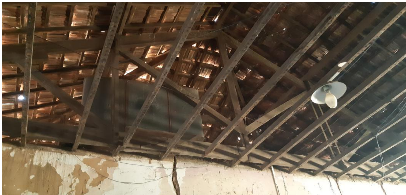
Detalhe da caixa d'água posterior apoiada no telhado e na parede. (Fonte autoral)
