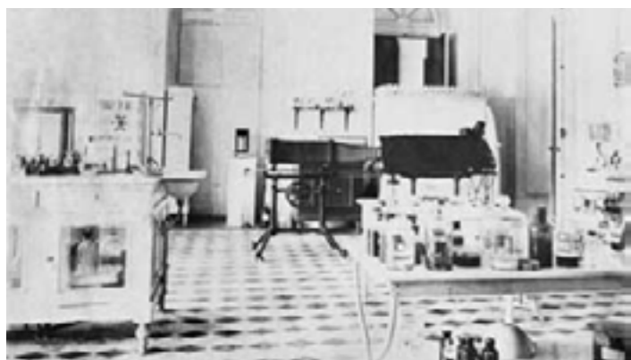
Imagem 4, 5 e 6: Instalações do Hospício de Pedro II
