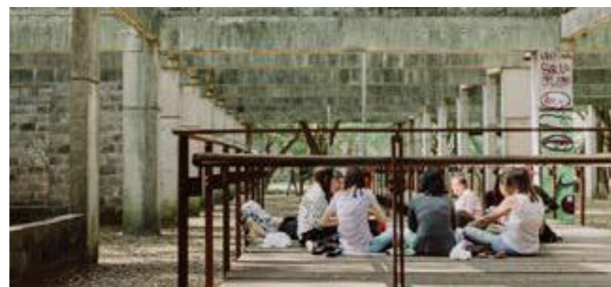
Imagem 61: Deck sob estrutura em ruínas
