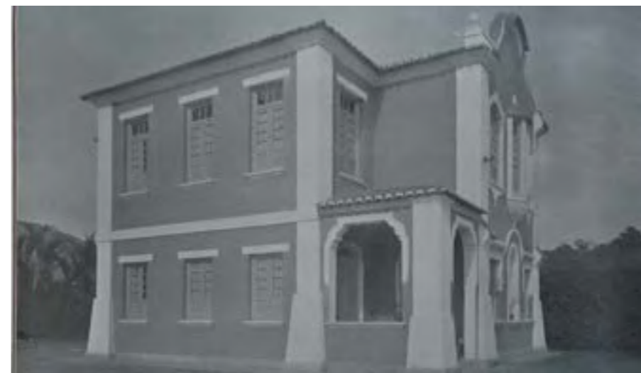
Imagem 16: Residência do Psiquiatra Assistente (1928) - Não existe mais
