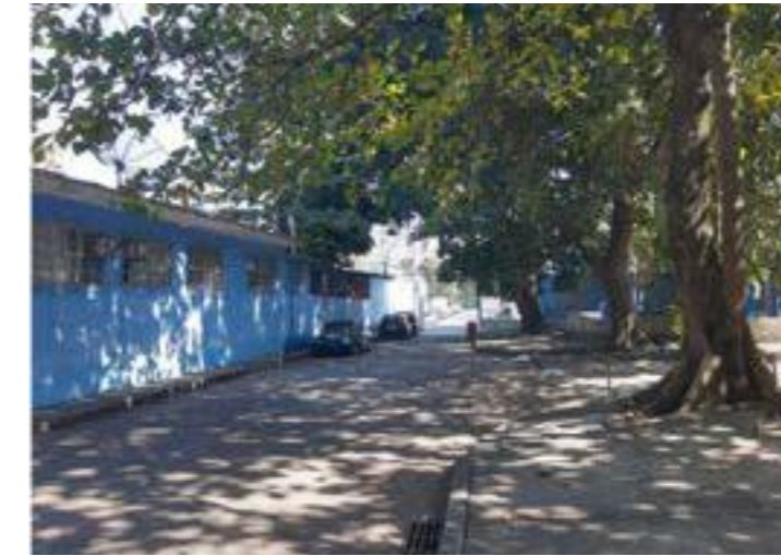
3_Lateral Escola Municipal / Acesso Rua Dois de Fevereiro
