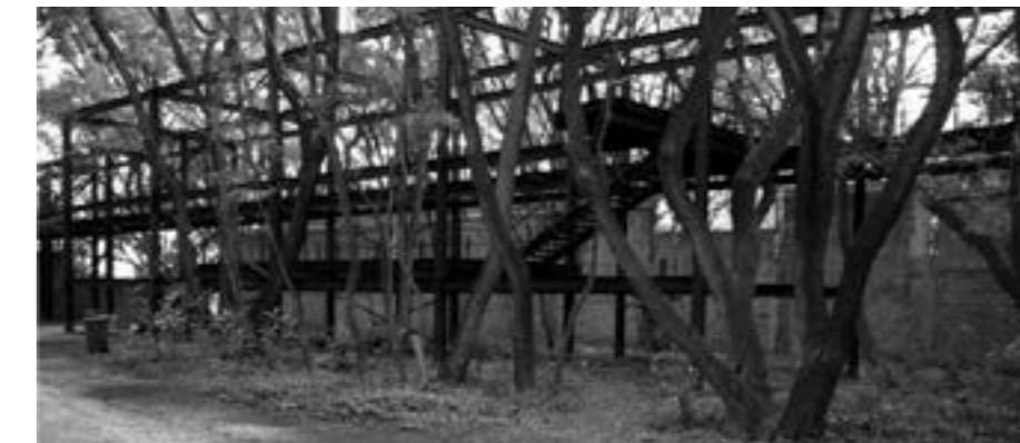
Imagem 63: Estrutura Metálica e acesso ao mirante
