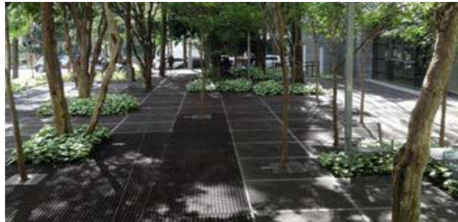
Imagem 68: Piso permeável em grelha metálica
