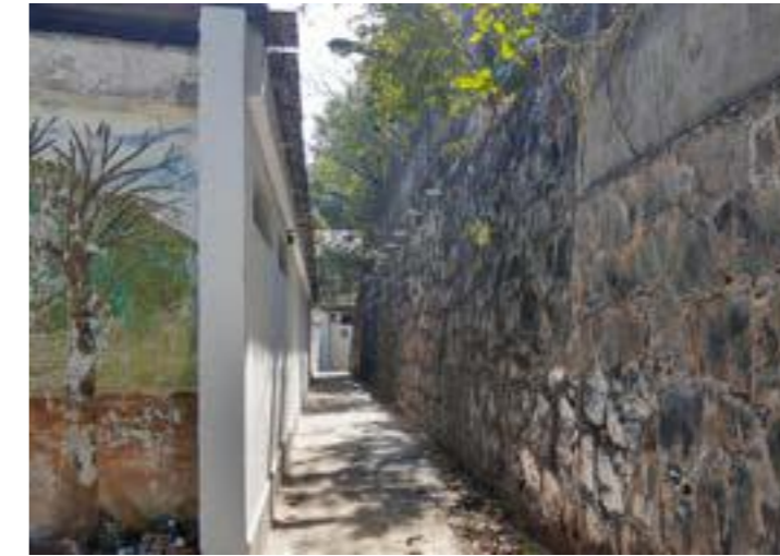
3_Fundos do Clube de Extensão Escolar e muro de arrimo
