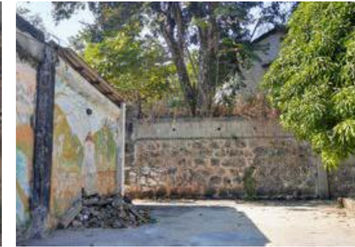
4_Muro de arrimo / Antiga residência (desocupada)
