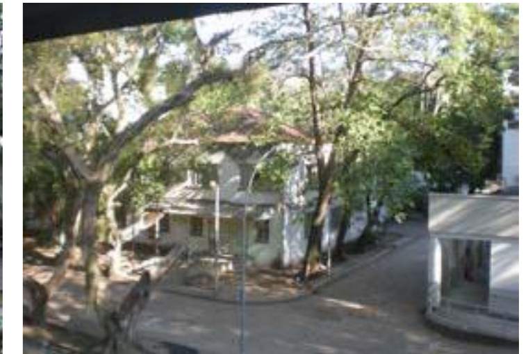
8_Vista da via de acesso / lateral da Casa do Sol
