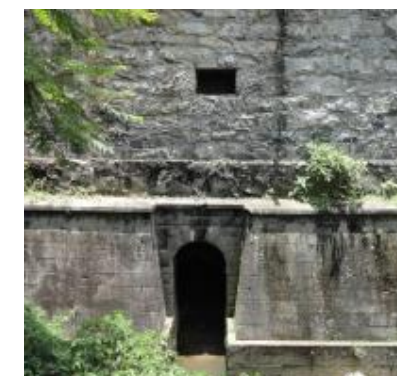
Saída de água existente Fonte: Arquivo Pessoal
