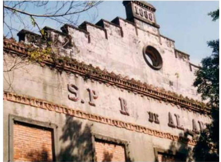
Frontão da Fachada com detalhes em pedra e tijolo
