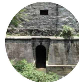
Túnel de saída das águas do canal
