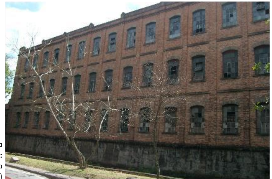
Fundação de pedra, vedações em tijolo cerâmico maciço, esquadrias metálicas com vedações de vidro
