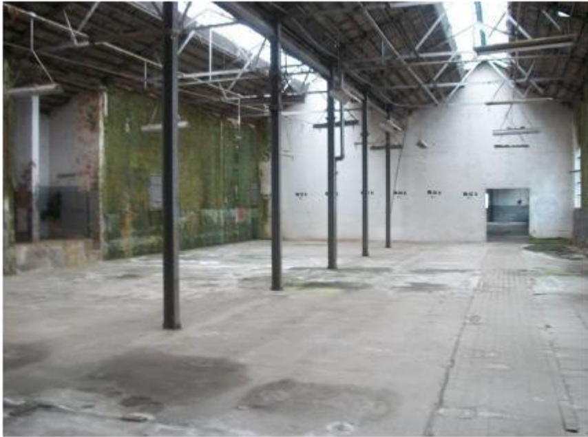
Estrutura Metálica e Telhamento Cerâmico
