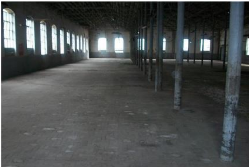
Último andar do edifício, onde é possível ver a estrutura de pilares metálicos cilíndricos do telhado
