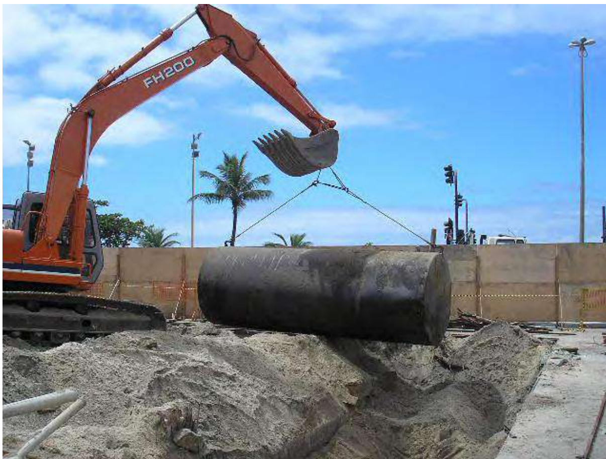
Figura V.10 – Retirada dos Tanques de Armazenamento do empreendimento
