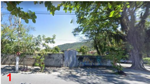
Visada do terreno da Avenida Rui Barbosa. Fonte: Website: https://www.google.com.br/maps/@-22.9187277;-43.0869939,3a,75y,336.75h,91.43t/data=!3m6!1e1!3m4!1s0KqCo_BiiNGVHFJbliMZpAI2e0!7i16384!8i8192
