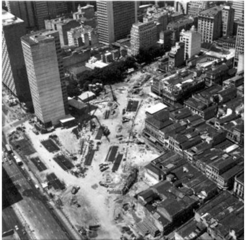
(Fig.2 ) Av. Presidente Vargas e obras do metrô Uruguaiana
