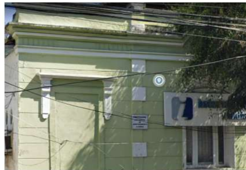
Esquadria da fachada
