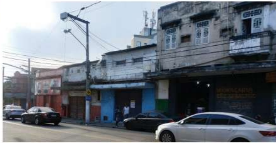
Edificações destinadas ao comércio Foto: Acervo pessoal
