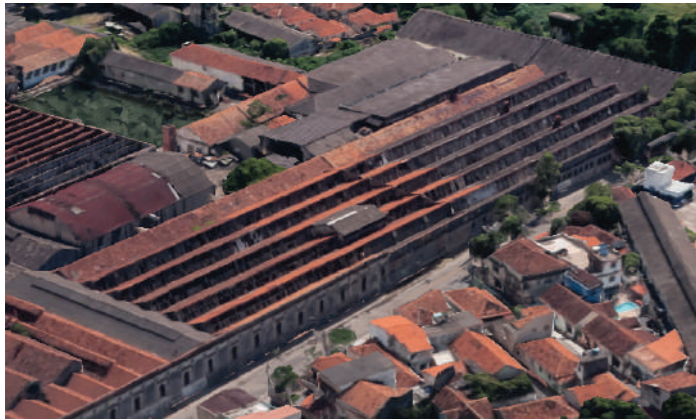
Detalhe da cobertura em sheds. Foto da fachada da Rua Guimarães Júnior.
