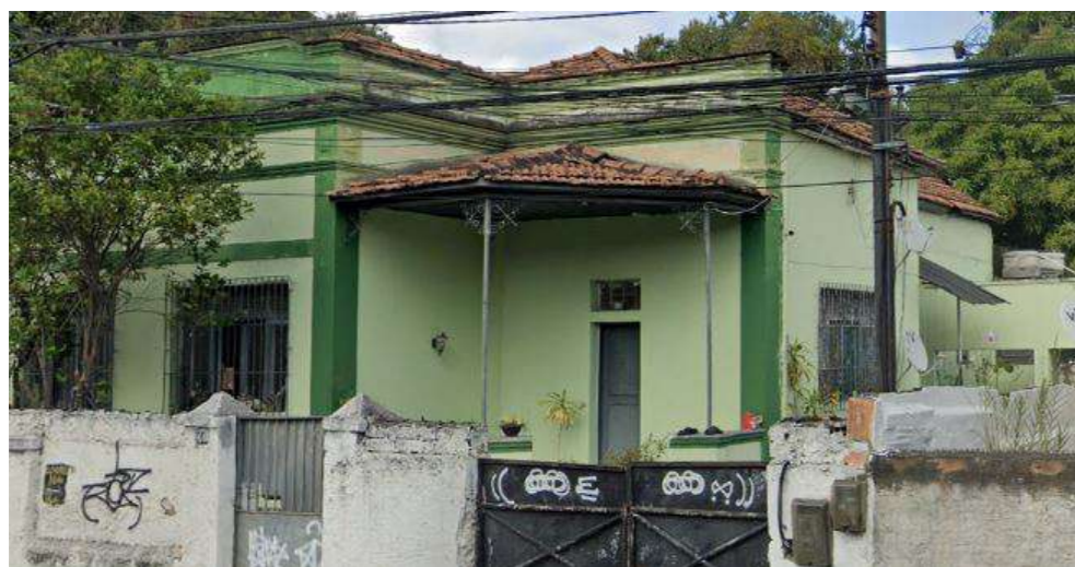
Fachada das casas geminadas.
