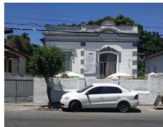
Fachada principal. Foto: Acervo pessoal
