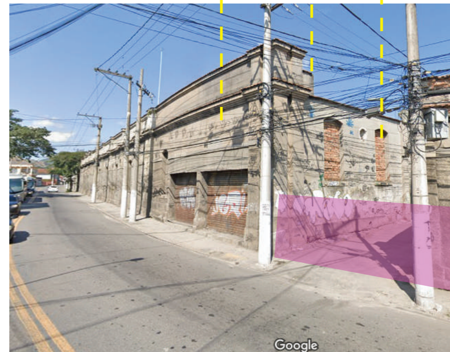
Foto atual em um ângulo mais próximo ao da foto acima no ano de 1920. A partir dessa foto vemos algumas alterações importantes na platibanda, nas colunas, nas aberturas de janelas. Nessa foto já temos a abertura onde é uma das vilas operárias, o que indica construção posterior a 1920.
