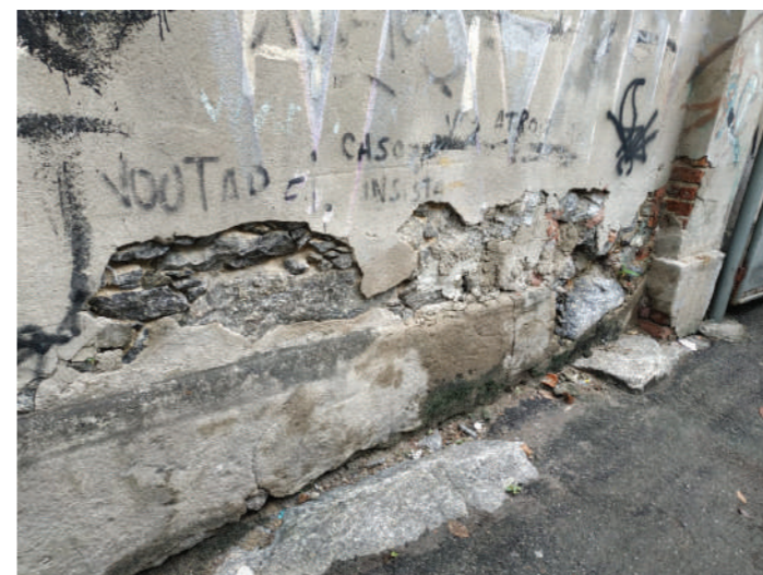
Tijolo maciço indicando o método construtivo da fábrica, tanto na função vedação quanto na função estrutural. Foto: Acervo pessoal
