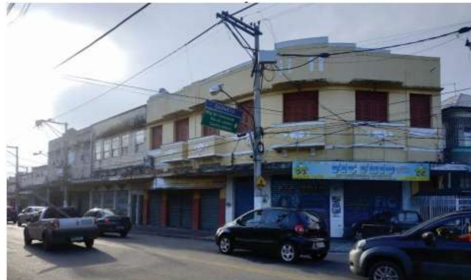
Edificações destinadas ao comércio Foto: Acervo pessoal
