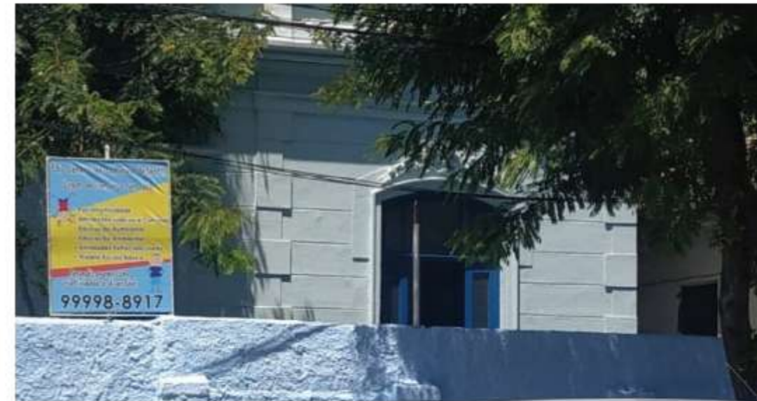
Fachada principal Foto: Acervo pessoal
