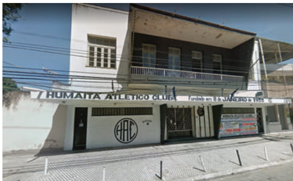
FACHADA DO CLUBE HUMAITÁ- FUNDADO EM 1933 FONTE: GOOGLE STREET VIEW
