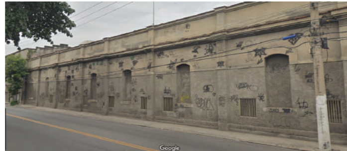
Platibanda na fachada principal.
