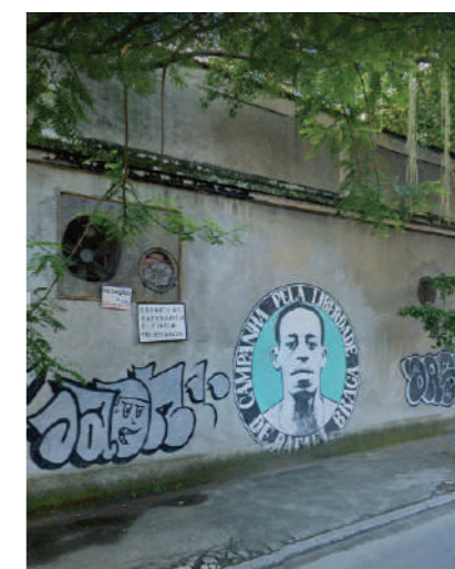
Detalhe dos exaustores. Elemento construtivo importante para esse tipo de edificação. Foto: Google Street View
