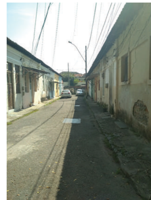
Nessa foto dá para ver parcialmente alguns problemas de conservação.
