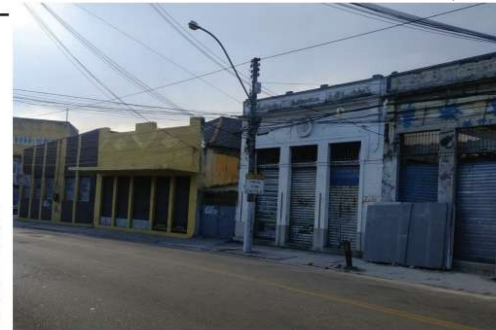
Edificações destinadas ao comércio Foto: Acervo pessoal
