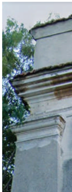
A cornija em evidência. Foto: Google Street View
