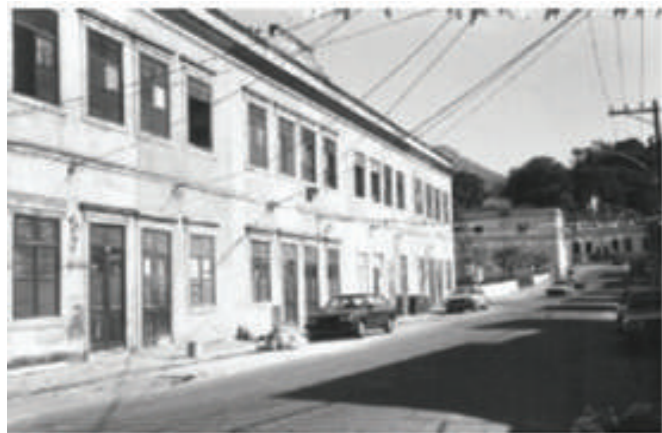
Rio de Janeiro Casas erguidas pela Companhia de Fiação e Tecidos Confiança Industrial
