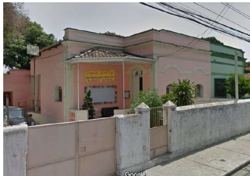
Fachada das casas geminadas. So temos 2 casas do mesmo modelo.
