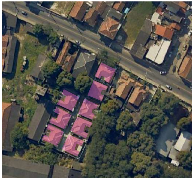
Caimento das águas do telhado.
