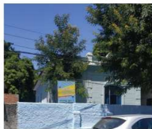
Fachada principal Foto: Acervo pessoal
