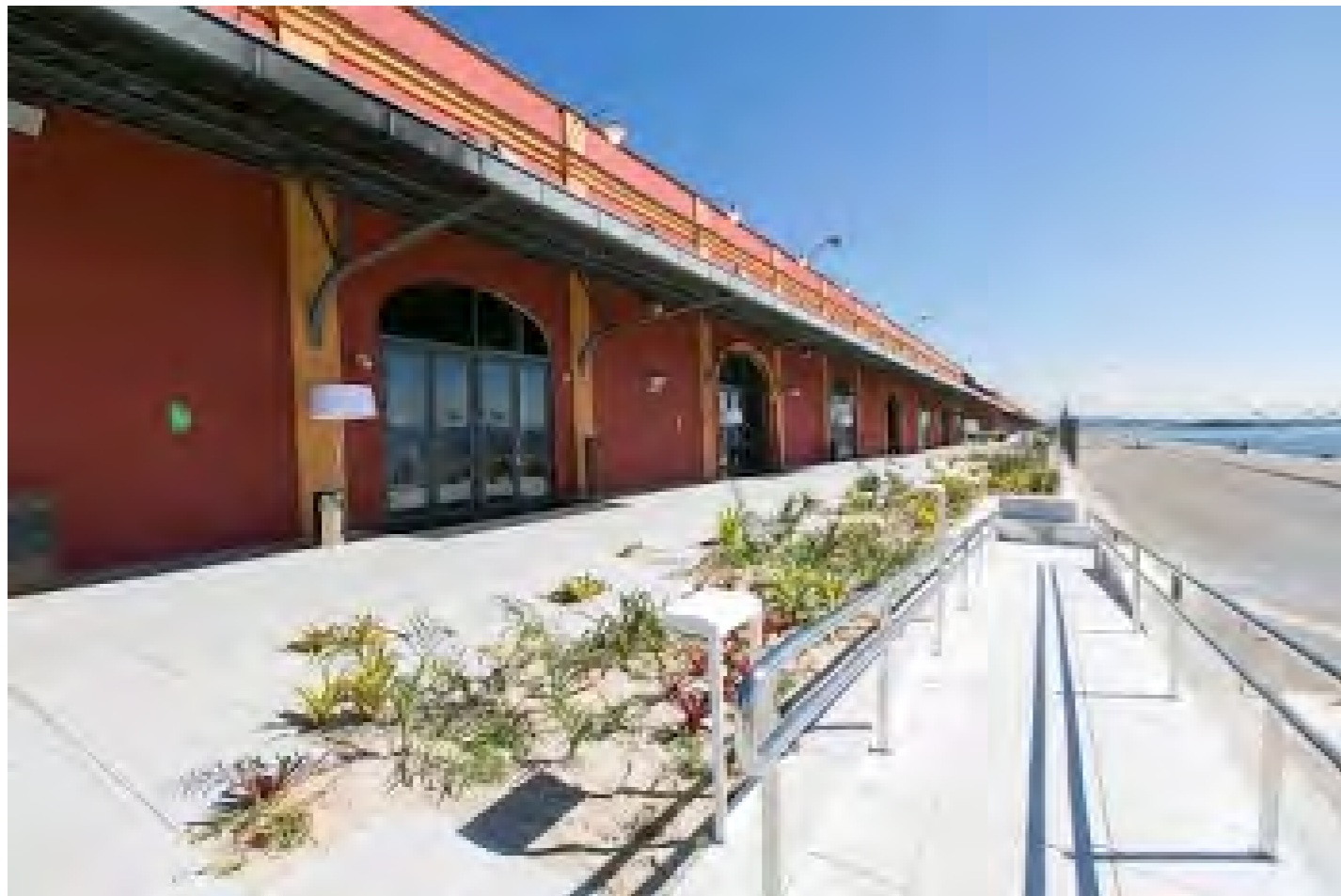
Figura 14: Deck do Armazém 1, com paisagismo na área externa, voltado para a paisagem da Baía de Guanabara. Fonte: YouTube Space Rio.
