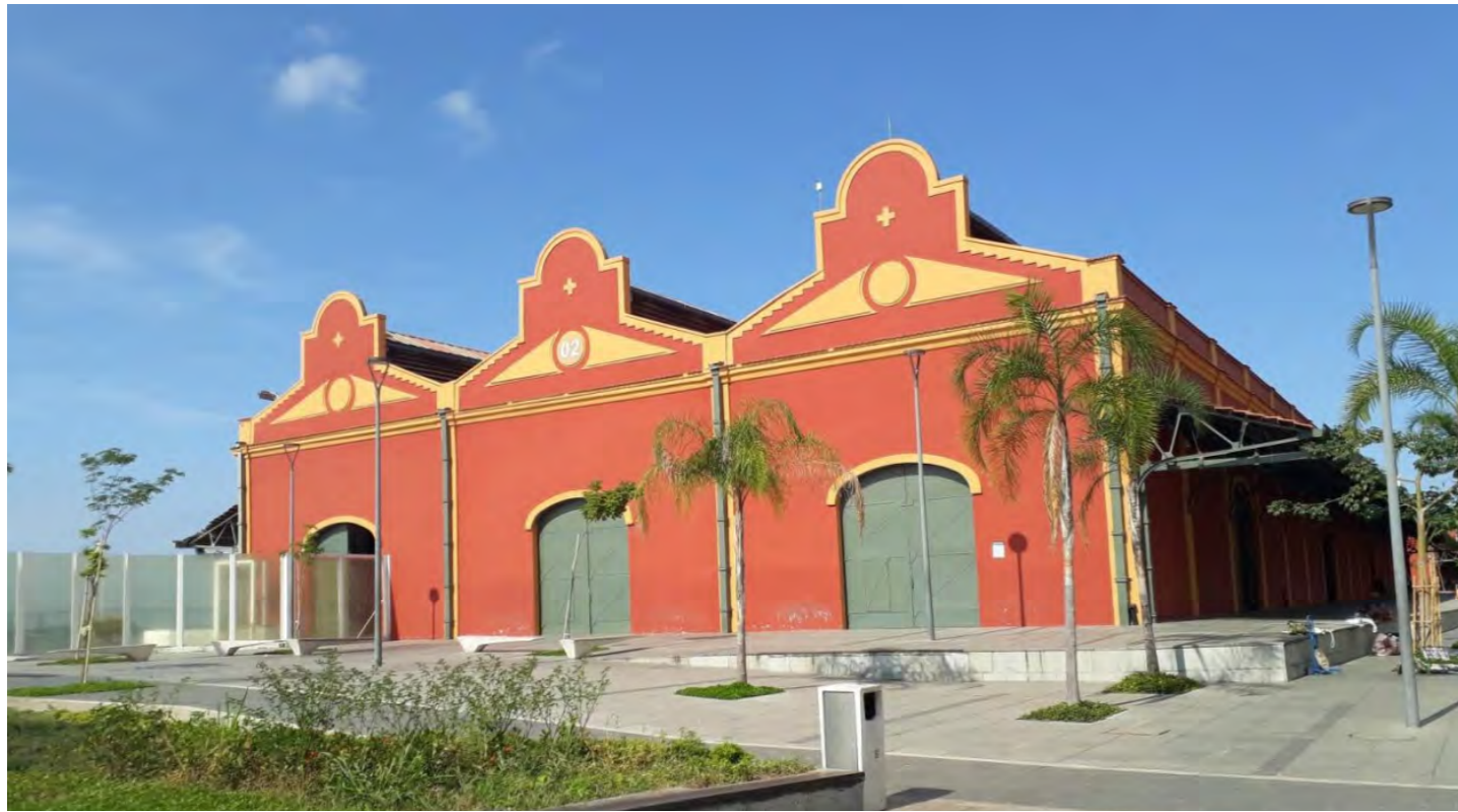
Figura 75: Foto externa do Armazém 2. Fonte: Wikimapia.
