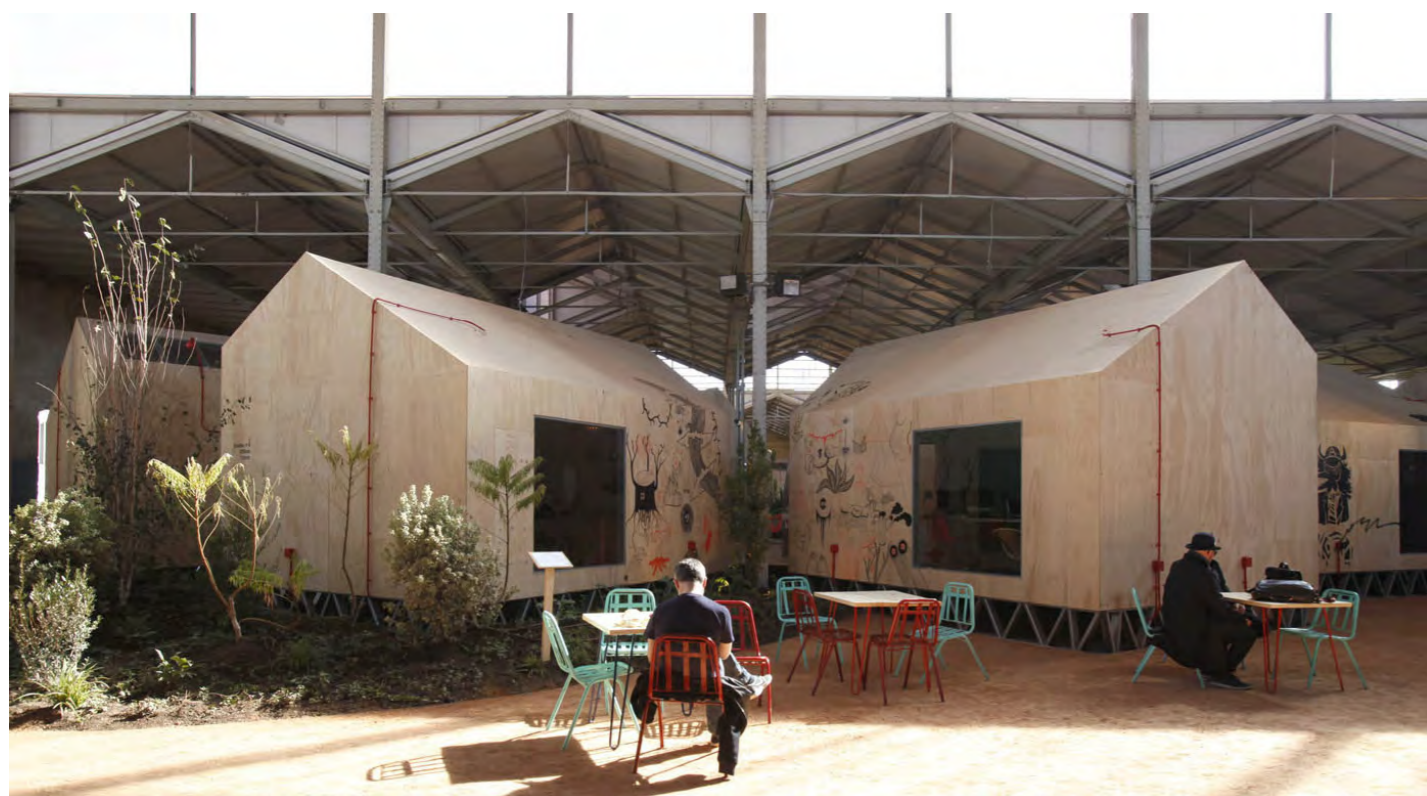
Figura 47: Estrutura de aço do galpão e fachadas preservadas. Criação de jardim e deck. Fonte: Archdaily
