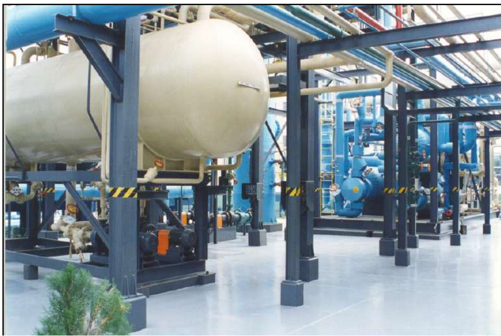
Fig. 4.4 – Foto de uma unidade de purificação e liquefação de CO2, evidenciando o tanque de estocagem de CO2 líquido. Fonte: Apresentações internas da White Martins
