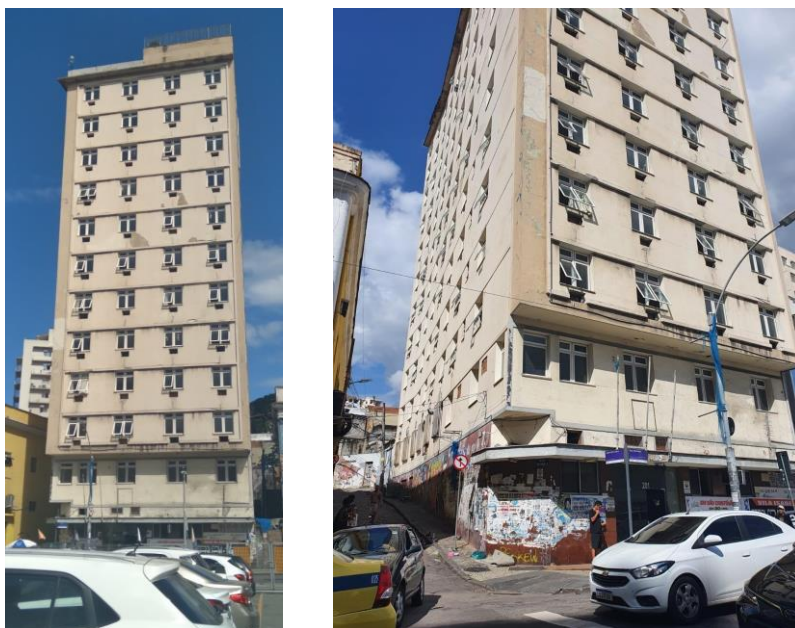
FIG. 1 - FACHADA DO HOTEL RIO'S NICE (EXISTENTE).
