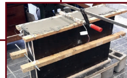
Figura 21: Fôrma após ser efetuada a concretagem.
