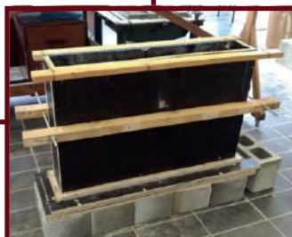
Figura 20: Fôrma montada e pronta para ser iniciada a concretagem
