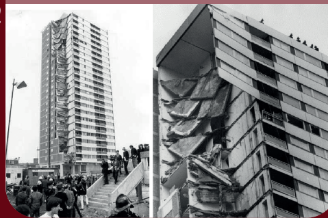
FIGURA 11: COLAPSO DA TORRE RONAN POINT, CONSTRUÍDA EM LONDRES, COM 22 PAVIMENTOS, EM 1968.
