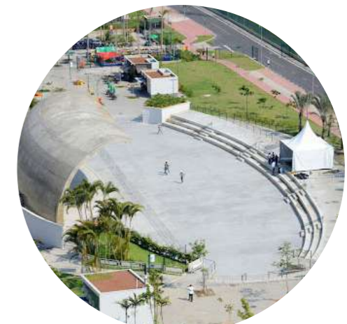
Topografia sendo utilizada para possibilitar a construção de uma arquibancada - Parque de Madureira.
