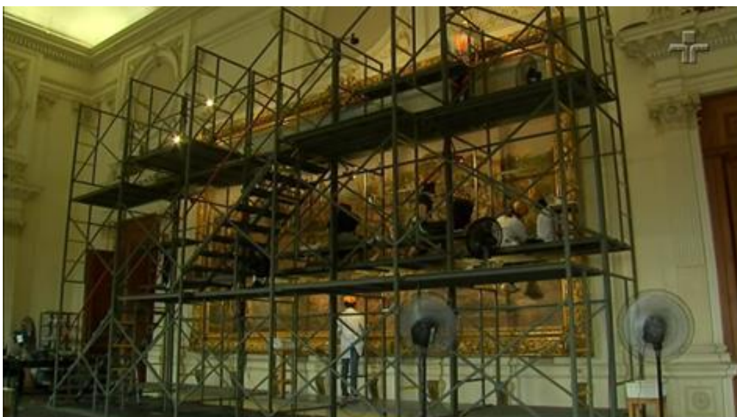
Figura 102: Imagens de andaime de trabalho
