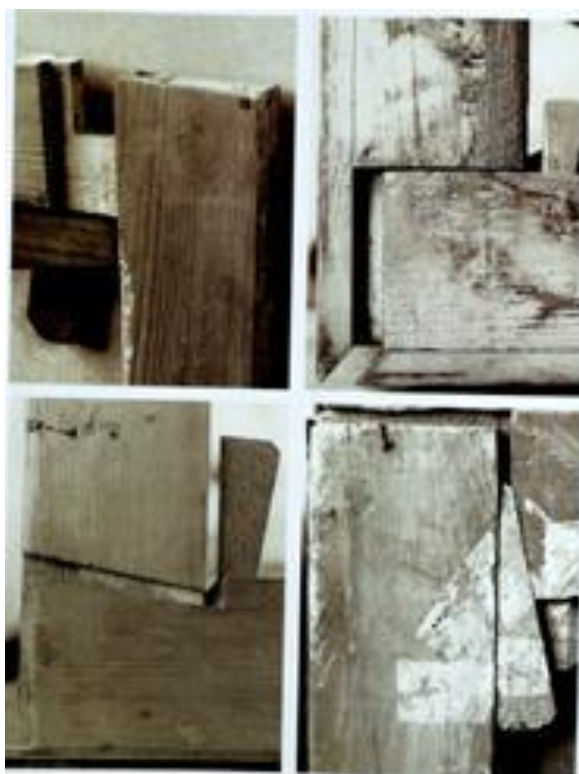
Figura 10: Chassi de junta expansível, encaixe espiga e cunhas
