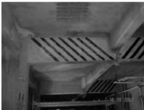
Figura 5: Reforço de viga ao corte com fibra de carbono (MACHADO, 2009).
