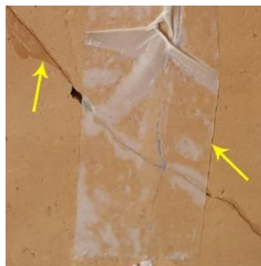
Figura 34 – Detalhe de utilização de fita adesiva na consolidação do suporte e extravasamento de adesivo em rachadura.
