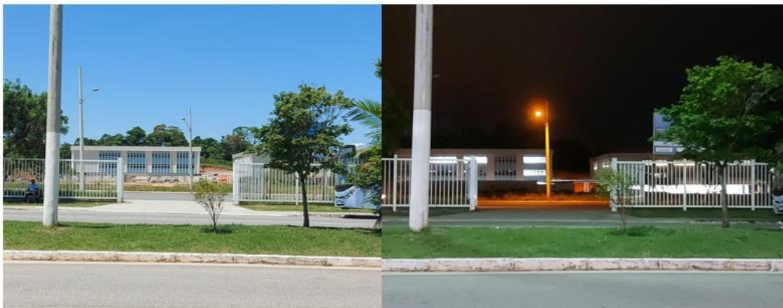
Figura 12 - Portão provisório de acesso na lateral da Cidade Universitária, durante o dia e durante à noite. FONTE: Autoria própria (2022).
