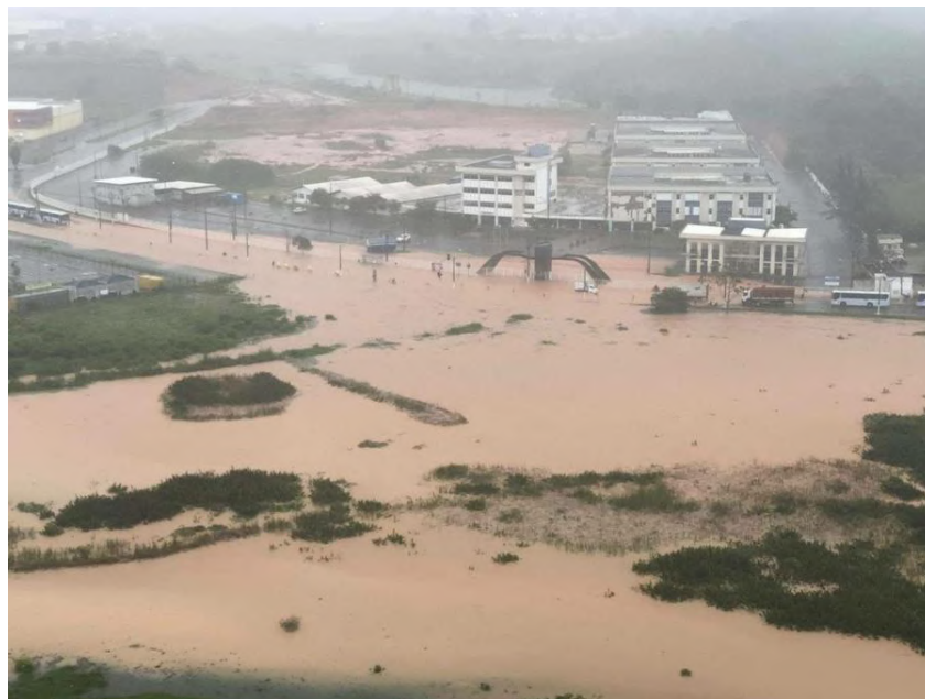
Figura 3 - Vista área da Cidade Universitária alagada após uma chuva intensa em Macaé. FONTE: Site Clique Diário (2018).
