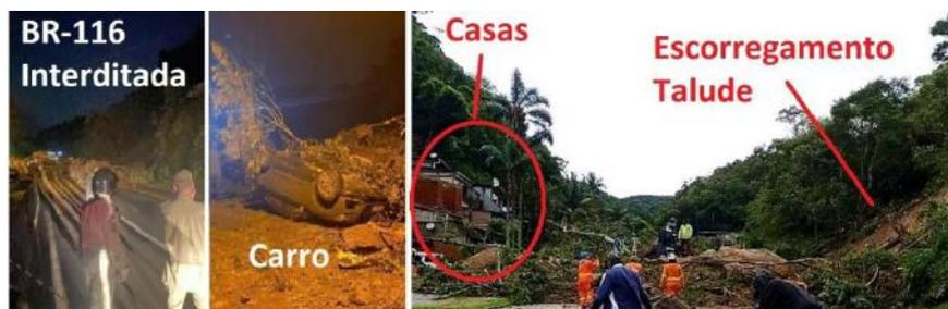
Figura 3.2 BR 116 bloqueada no km 84 e carro atingido pelo deslizamento do talude (Adaptado de Multiplix<sup>18</sup>)
