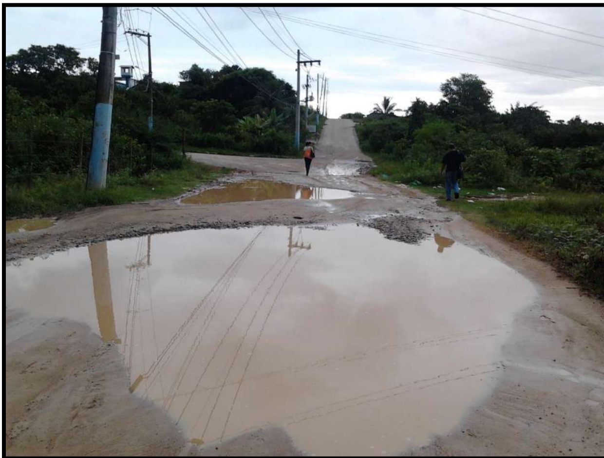
Figura 3 – Asfaltamento apenas da via principal e início do acesso as unidades prisionais Cotrim Neto e Milton Dias Moreira, a grande poça de água é o início do acesso ao João Carlos da Silva.
