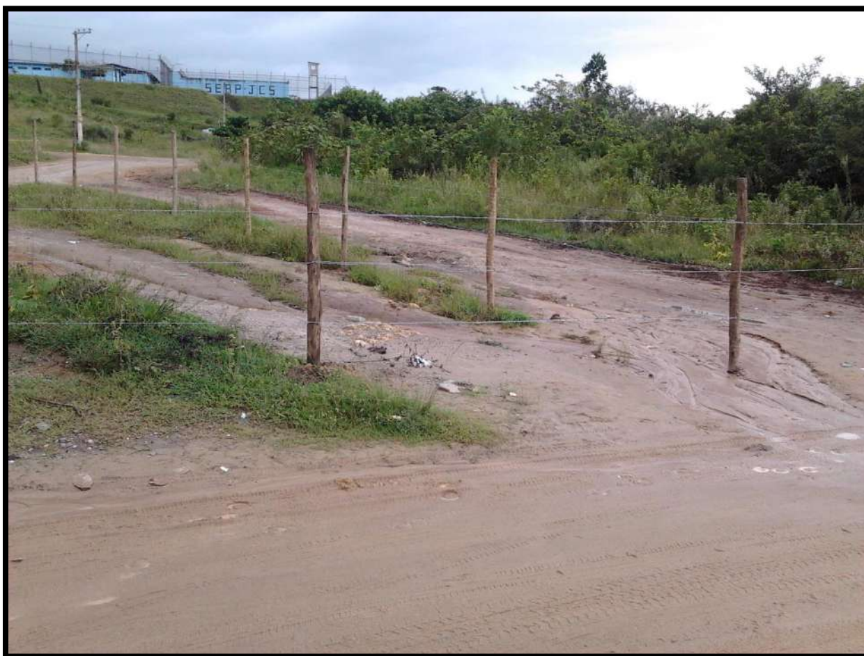
Figura 5 – A via de acesso ao João Carlos da Silva não foi asfaltada
