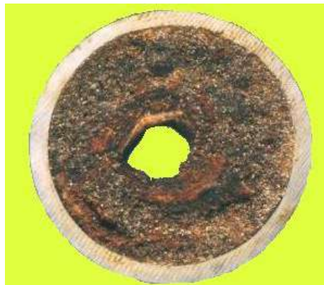
Figura 1-3 – Deposição de asfaltenos em um trocador
