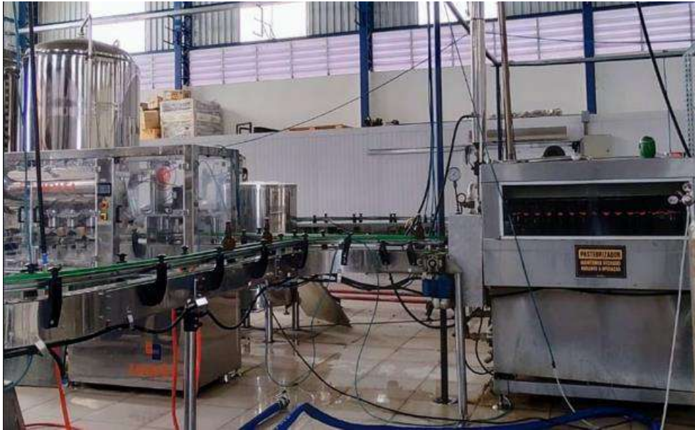
Figura 19 – Envasadora (à esquerda) e entrada do túnel pasteurizador (à direita)
