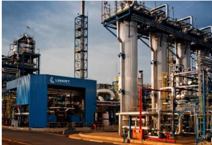
Figura 2.17 – Planta de rerrefino de OLUC da Lwart Soluções Ambientais Ltda.
