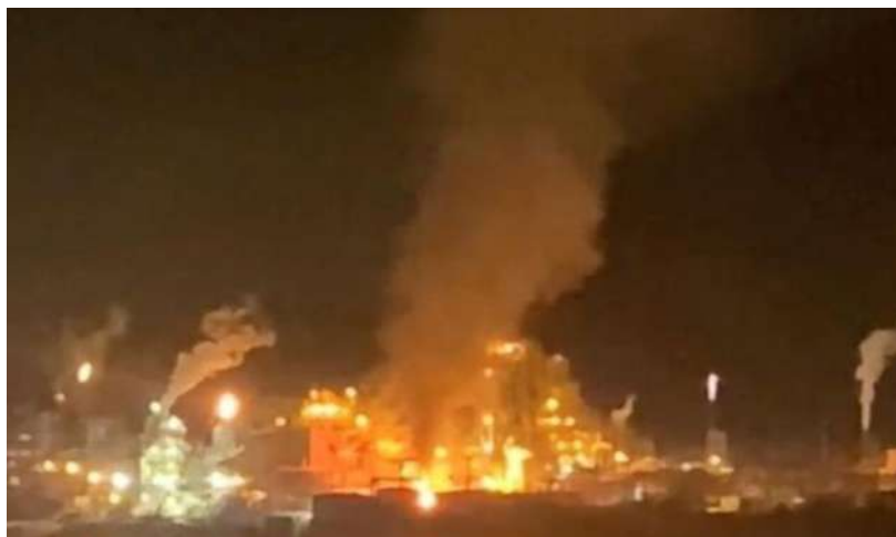
Figura 4.3 – Incêndio após a explosão do secador da Optima Belle
