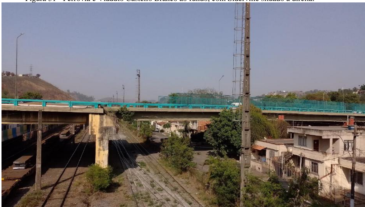
Figura 31 - Ferrovia e Viaduto Castelo Branco ao fundo, com Siderville situado à direita.
