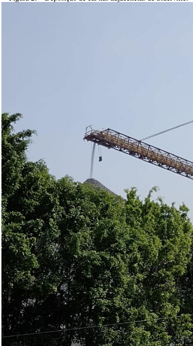
Figura 29 - Deposição de cal nas adjacências de Siderville.
