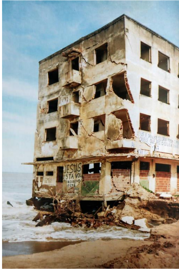
Figura 22: Prédio do Julinho, antes do desabamento.
