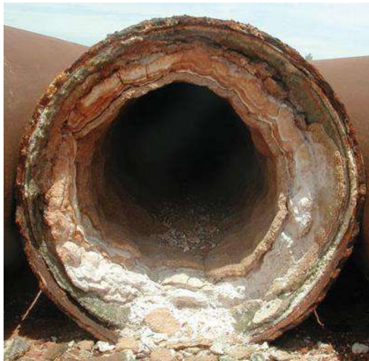
Figura 2.1 - Exemplo de tubulação afetada pela formação de scale
