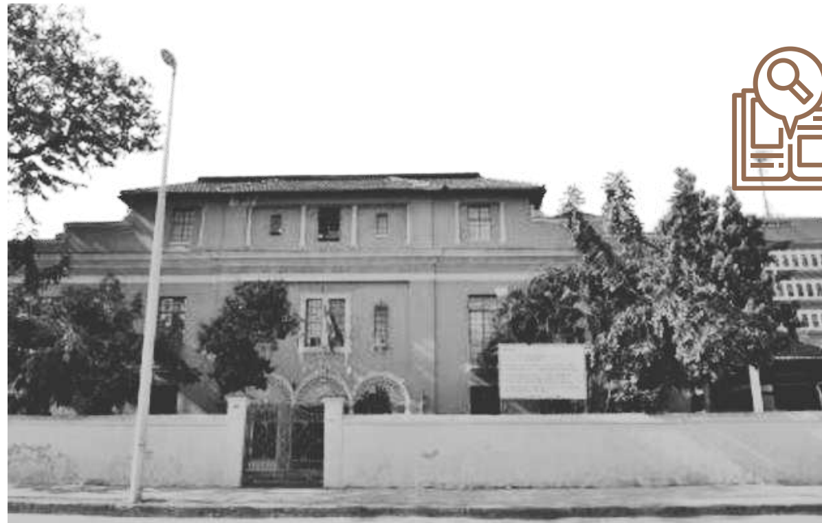
FIG. 02: FACHADA PRINCIPAL DO EDIFÍCIO DA INSTITUIÇÃO.
