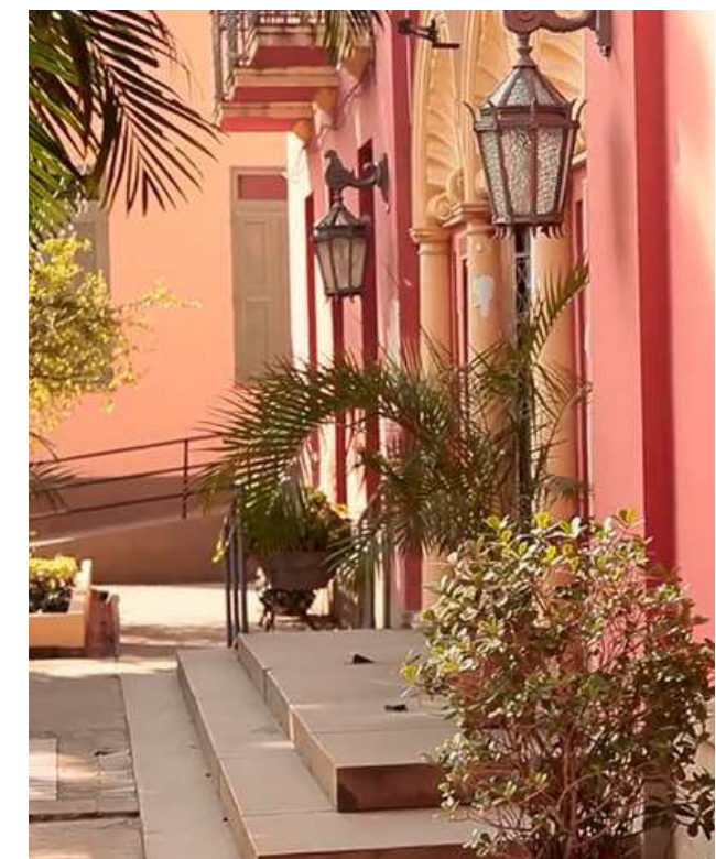
FIGS. 03: ESCADA DE CIRCULAÇÃO VERTICAL E ESCADA NA FACHADA PRINCIPAL.
