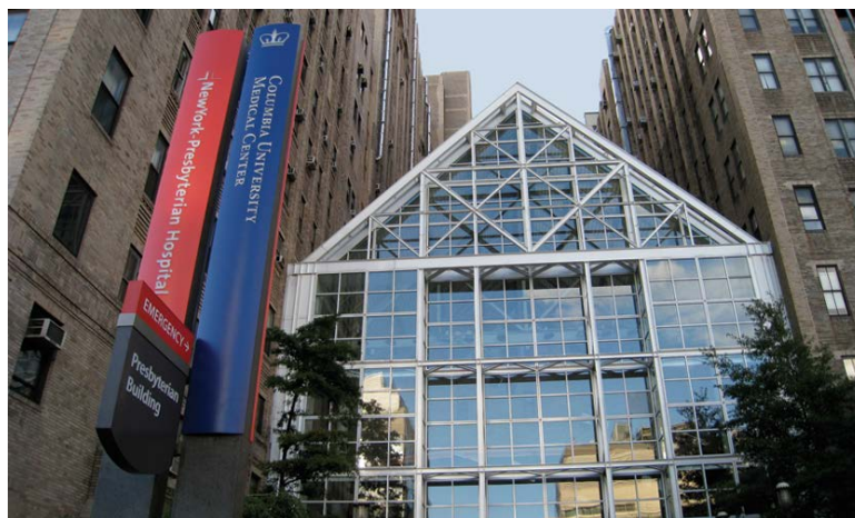
Figura 5: Sinalização do Hospital Presbiteriano de Nova York
