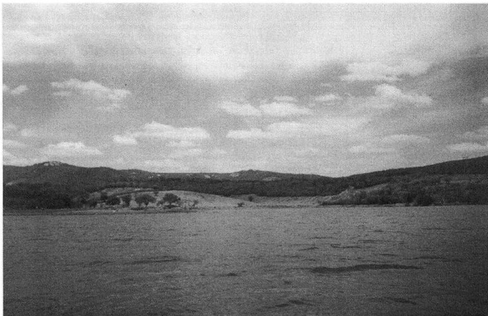
Figura 2 – Vista parcial do Reservatório Tabocas (novembro - 1997).
