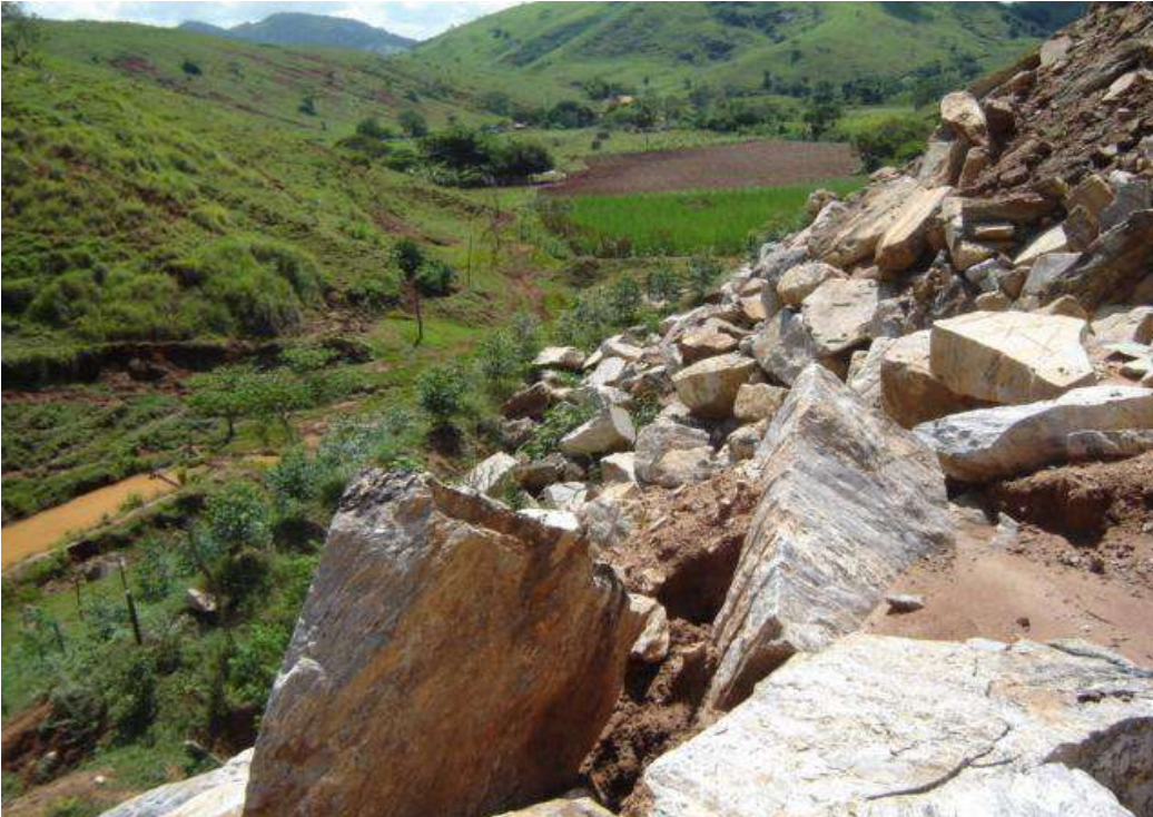
Foto 4- Área de bota fora do aproveitamento, mostrando plantio de eucaliptos na base.
