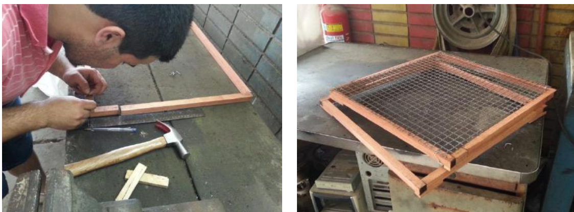
Figura 48. Processo de construção das molduras de madeira e amarração da grade de ferro. Fotos da autora.
