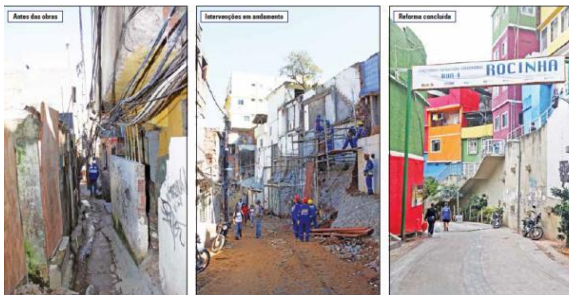
(Imagem 11 – Urbanização da Rua 4 – FONTE: http://www.rj.gov.br/web/imprensa/exibeconteudo?article-id=1179809 )
