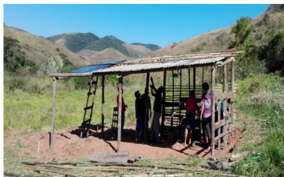
Figura 10. Foto da estrutura do galpão construído depois de instalado o sistema. Fonte: próprio autor
