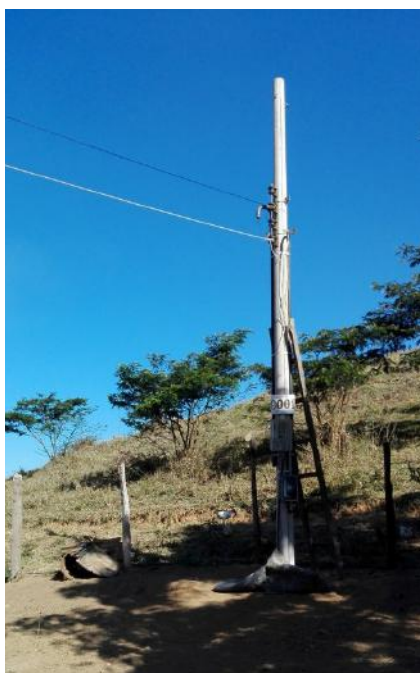
Figura 13. Foto do poste de luz construído no NB 3 segundo o padrão da Light. Fonte: próprio autor
