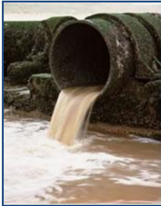
Figura 1: Efluente lançado sem tratamento em um rio 6
