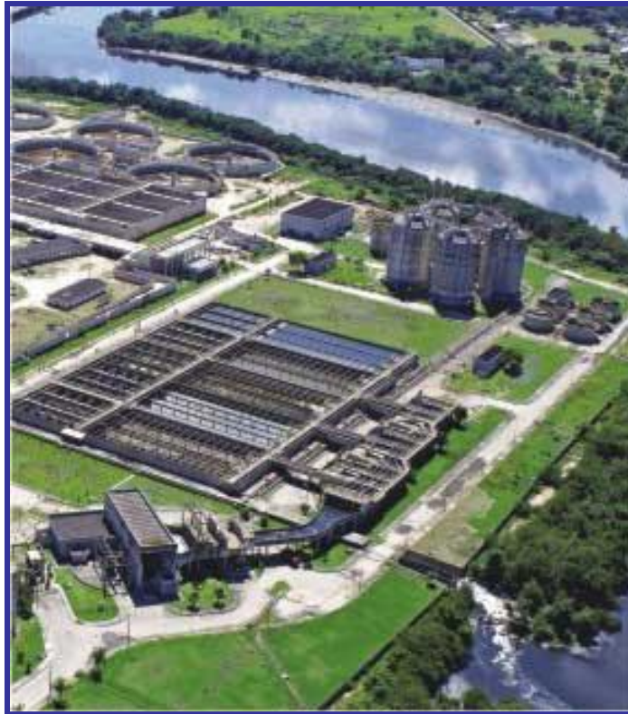
Figura 2: Estação de Tratamento Alegria da CEDAE, para despoluição da Baía de Guanabara. É a maior das estações de tratamento da CEDAE 11
