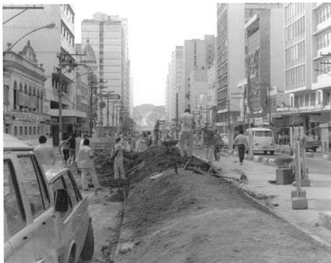
Figura 15 – Obras da canaleta central exclusiva para ônibus
