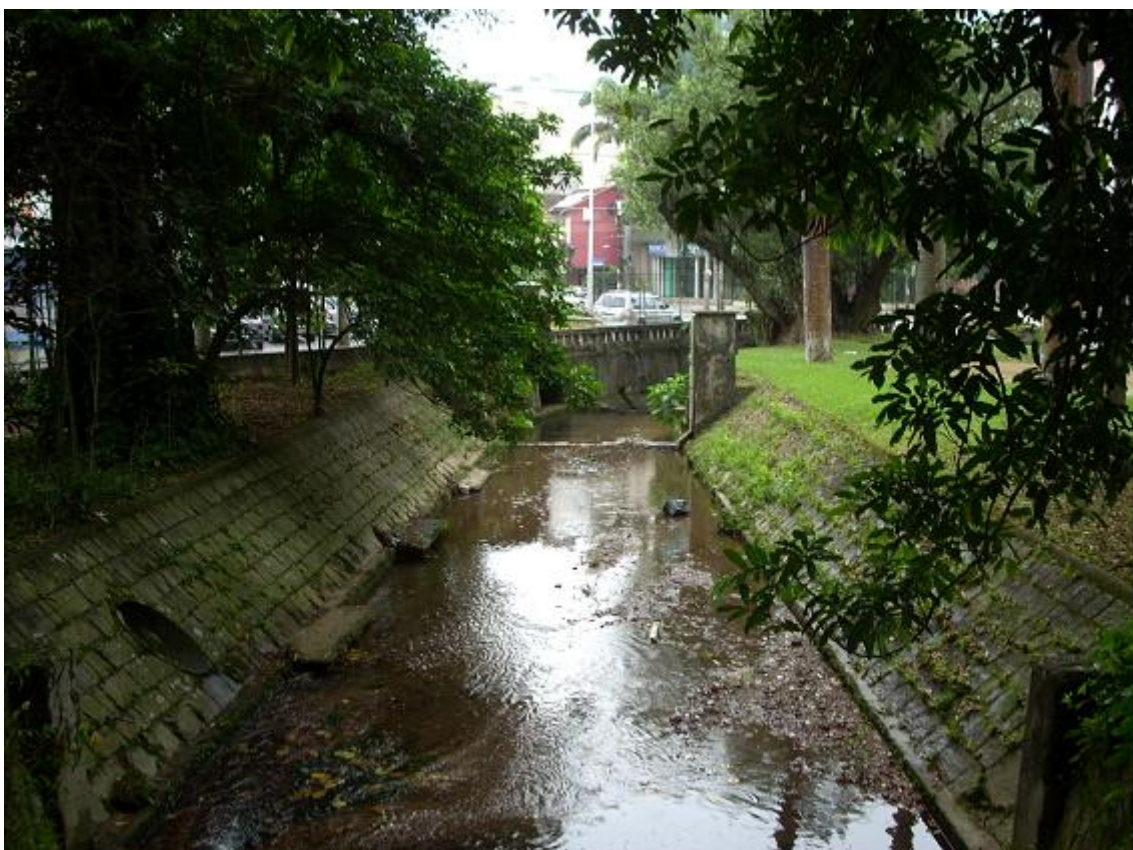
Figura 30: Vista do rio dos Macacos pouco antes de entrar em galeria, sob a rua Jardim Botânico (fonte: acervo pessoal do professor Marcelo G. Miguez).
