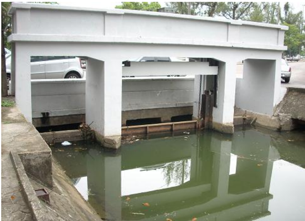
Figura 36: Detalhe da comporta - rua General Garzon (fonte: acervo pessoal do professor Marcelo G. Miguez).
