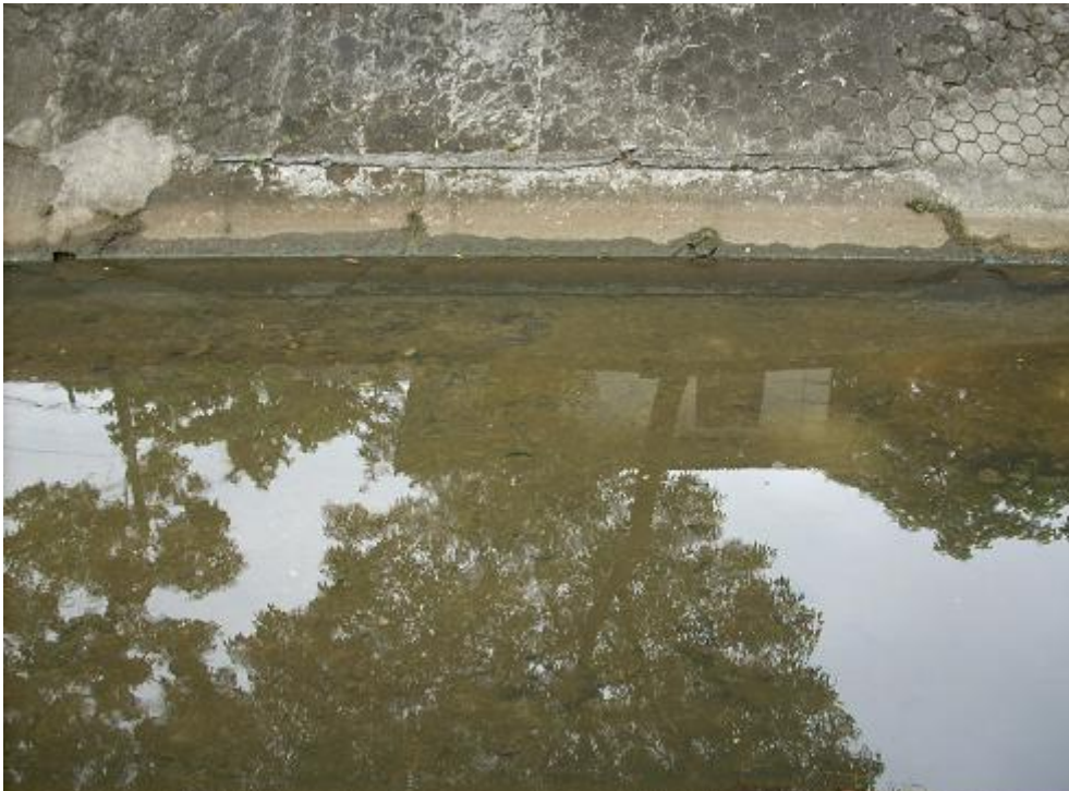
Figura 34: Detalhe do rio dos Macacos no canal da rua General Garzón – baixa lâmina d'água e assoreamento(fonte: acervo pessoal do professor Marcelo G. Miguez).
