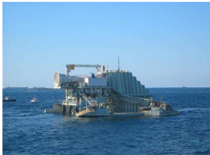
Figura 2.6: Central Energetech – Austrália Ref.:Rudge 2005
