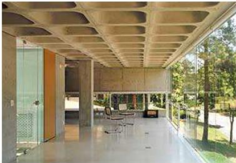
Figura 4: Aspecto final de uma laje nervurada. RIOS (2008).
