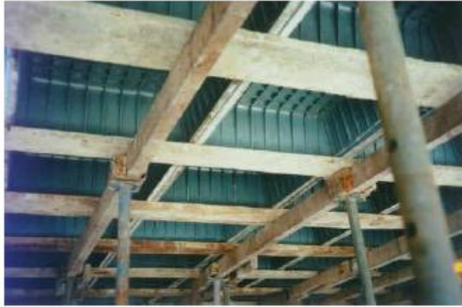
Figura 2: Detalhe das formas de polipropileno sobre escoramento. RIOS (2008).
