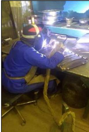
*Figura 3-9 Soldador conduzindo a soldagem e utilizando os equipamentos de proteção individual pertinentes.*
