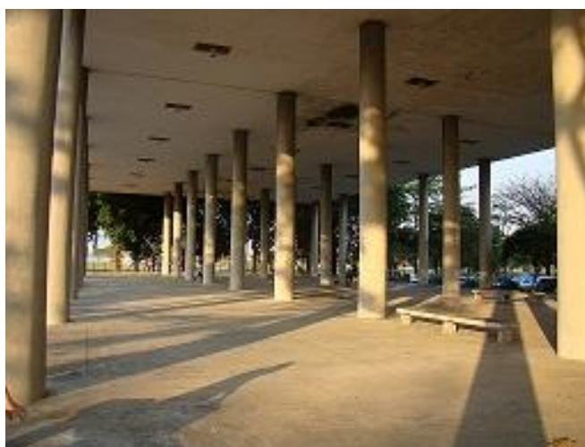
Figura 3.1: Vista dos pilares existentes.
