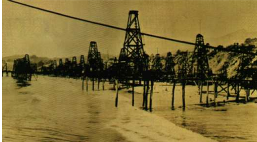
Figura 2 - Primeiro poço offshore em Summerland, Califórnia
