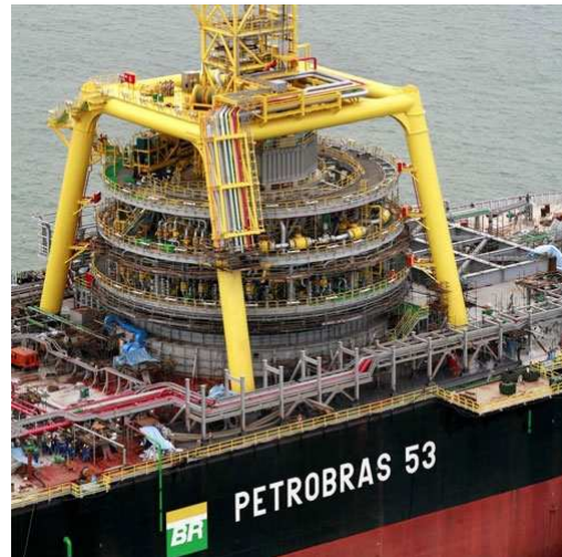
Figura 17 - Turret interno do FPSO P-53
