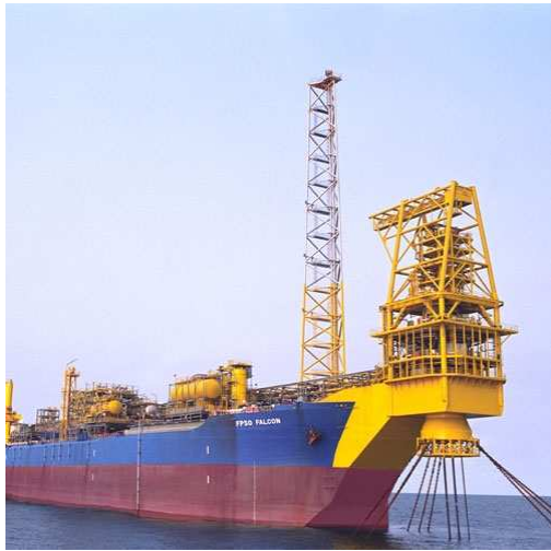
Figura 16 - Turret externo do FPSO Falcon
