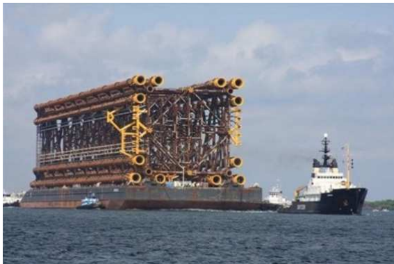
Figura 4 - Torre complacente Tombua Landana
