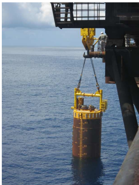
Figura 34 - Estaca de sucção utilizada na SPAR BUOY Perdido
