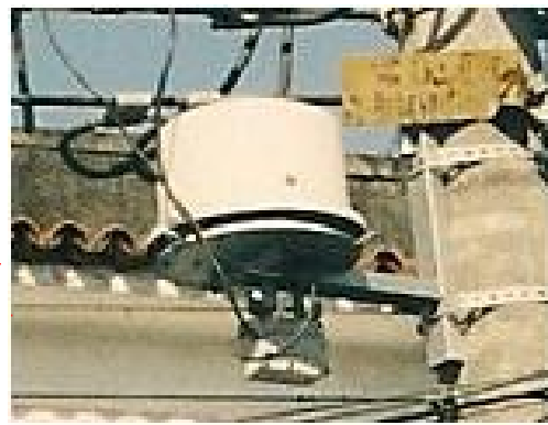
Figura 4.10: Primeira versão do Transmissor de Onda Portadora (a) Circuito interno (b) Em destaque na rede de distribuição de energia
