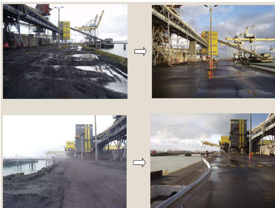
Figura 3-2: Melhorias na gestão de efluentes do terminal de carvão no Port of Le Havre . Fonte: (ESPO, 2013a)
