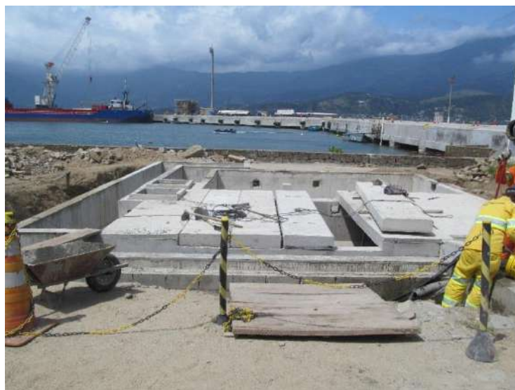
Figura 3-8: Sistema de tratamento da drenagem pluvial do porto em construção (Fonte: Projeto Resíduos Portuários, 2013)
