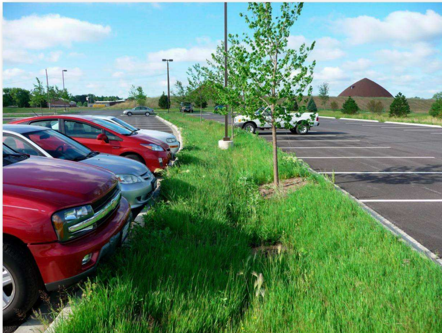
Figura 16 - Vala de infiltração em estacionamento, com plantas nativas (Fonte: http://www.lakecountvil.gov/Stormwater/LakeCountyWatersheds/BMPs/Pages/CPF.aspx em 29/04/2011)
