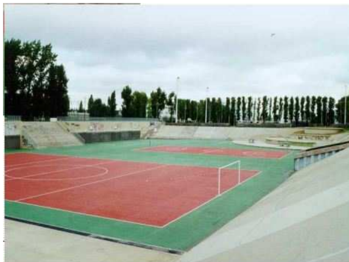
Figura 23 - Bacia de detenção aberta usada como área de lazer (Baptista, 2005)
