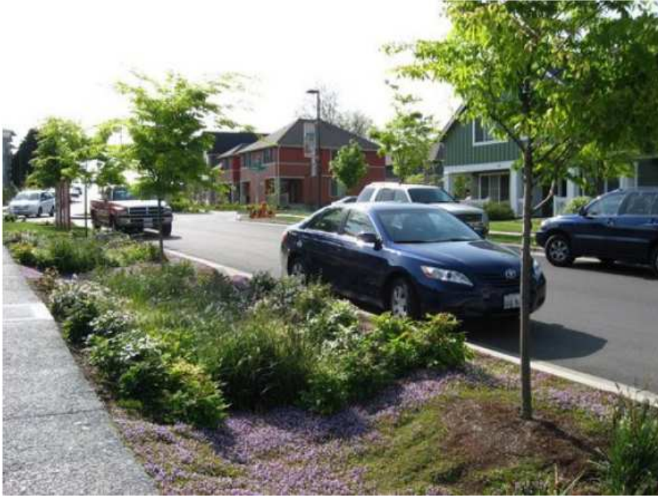
Figura 15 - Vala de infiltração em jardim (Fonte: http://en.wikipedia.org/wiki/File:Streetside_swale_Seattle.jpg , acessado em 29/04/2011)
