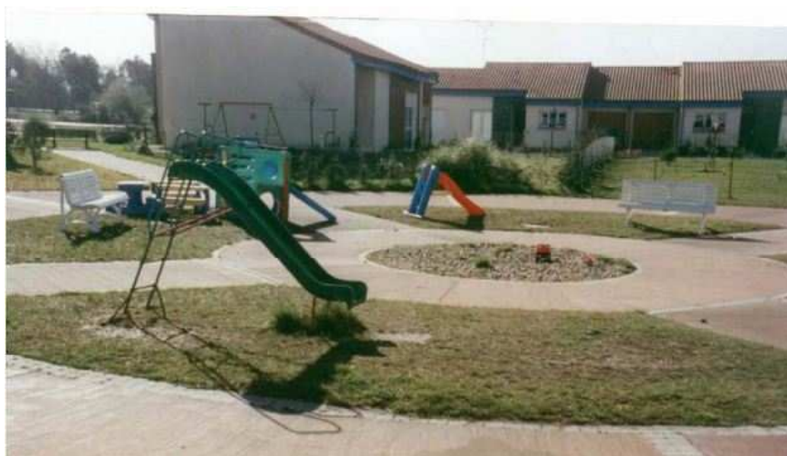
Figura 25 - Poço de infiltração em área de lazer. (Baptista, 2005)
