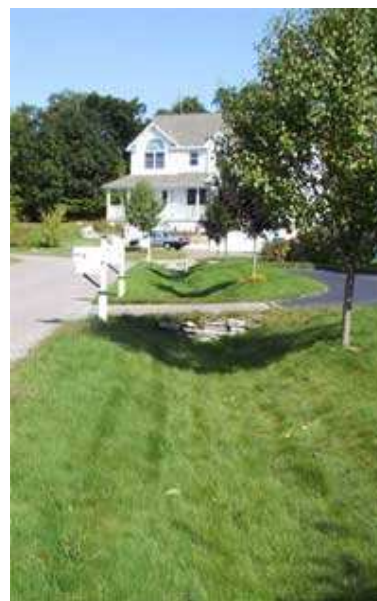
Figura 14 - Vala de infiltração ao longo de uma rua (Fonte: http://www.eot.state.ma.us/smartgrowth/07toolkit/LID/regional_planning/LID/swales.html acessado em 29/04/2011)
