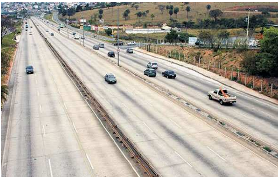
Figura 18 – Rodovia com pavimentos impermeáveis (Fonte: http://www.abcp.org.br/conteudo/imprensa/pavimento-de-concreto-no-anel-rodoviario-de-belo-horizonte , em 29/04/2011)
