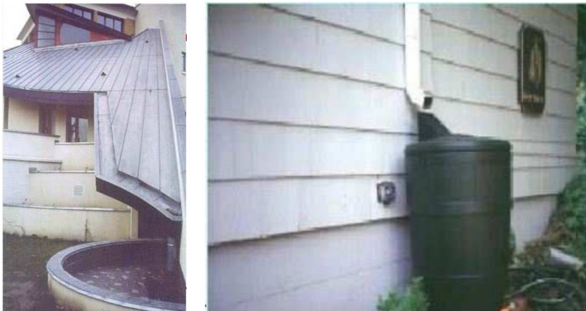
Figura 28 - Reservatórios Individuais para aproveitamento da água da chuva (Baptista, 2005)
