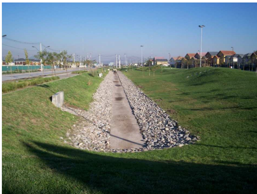
Figura 19 - Bacia de detenção em área residencial, aliado à áreas de lazer em Santiago, Chile (Fonte: acervo pessoal)
