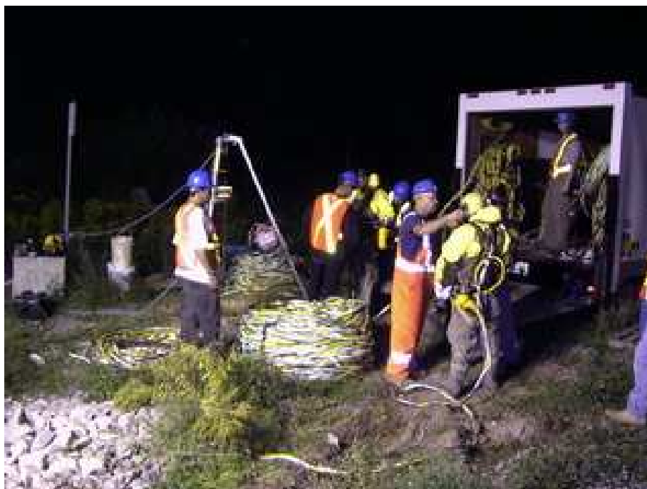
Figura 31 - Inspeção visual através entrada de operário. (Fonte: Pipeflo.ca, visitado em 29/04/2011)
