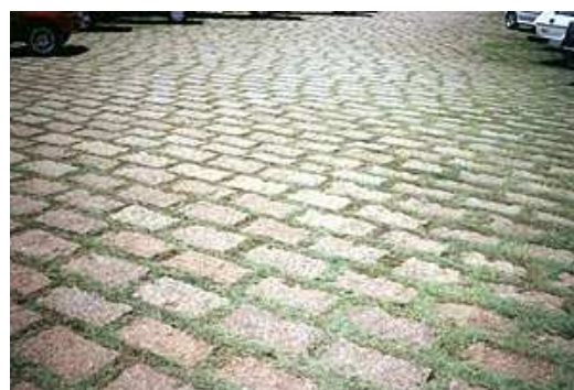
Figura 17 - Pavimento permeável em estacionamento (Fontes: http://www.araguaiapedras.com.br/ e http://www.brunolamas.com.br/noticias,373,pavimentacao_ecologica_nos_condominios_da_serra.html , em 29/04/2011
