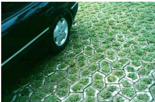
Figura 17 - Pavimento permeável em estacionamento (Fontes: http://www.araguaiapedras.com.br/ e http://www.brunolamas.com.br/noticias,373,pavimentacao_ecologica_nos_condominios_da_serra.html , em 29/04/2011
