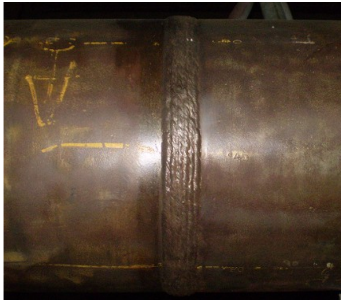
Figura 3.15 – Duto soldado com TIG na raiz e preenchido com eletrodo revestido.
