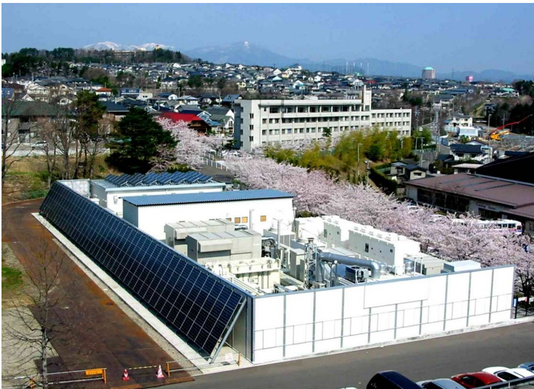
Figura 30: Foto do Centro de Energia do projeto Sendai.
