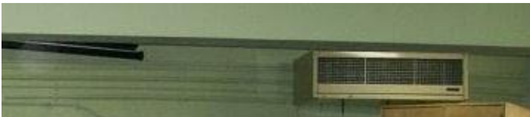
Figura 27 – Tubulação dos sistemas de refrigeração expostas ao ambiente
