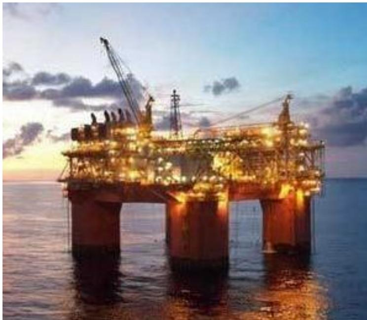
Figura 36 - Plataforma Semissubmersível (**NewsComex**)
