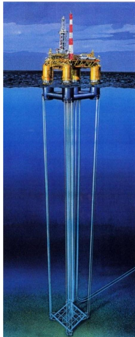
Figura 38 - Plataforma Tension Leg(**Abrantes**)
