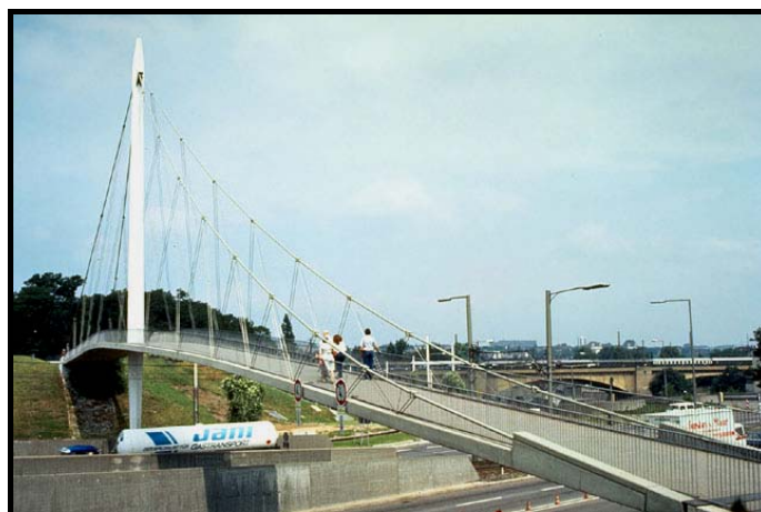
Figura I. 13 – Passarela Rosenstein, Estugarda, Alemanha (fonte: Structurae)
