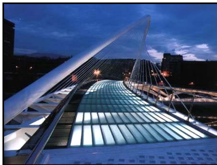
Figura I.6 – Outra perspectiva da passarela Campo Volatin, Espanha (fonte: www.metalicapontes.com.br )
