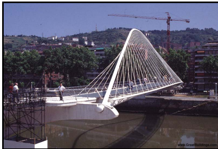
Figura I.5 – Passarela Campo Volatin, Espanha (fonte: www.metalicapontes.com.br )
