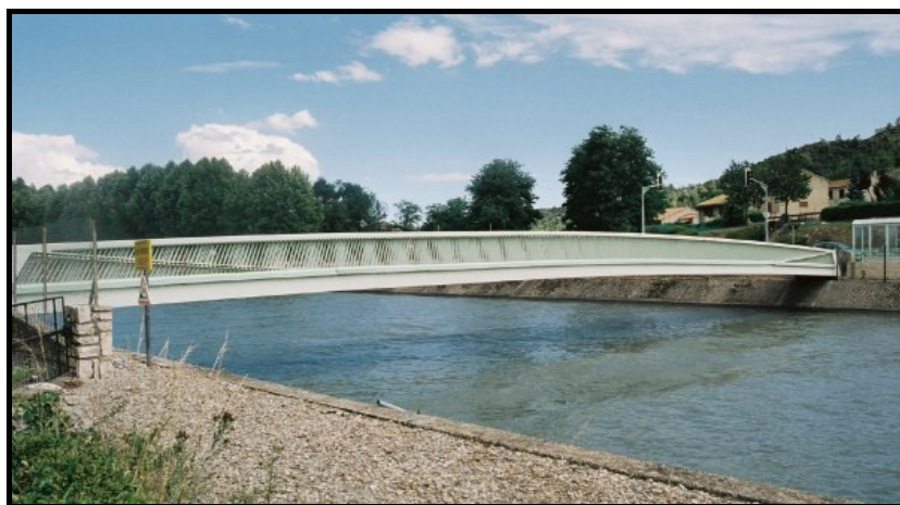
Figura I.15 – Passarela Mirabella, França (fonte: Structurae, fotógrafo: Nicolas Janberg).
