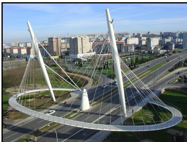
Figura I.9 – Passarela “La Rosa”, Espanha (fonte: Structurae, fotógrafo: António Gozalez Serrano).
