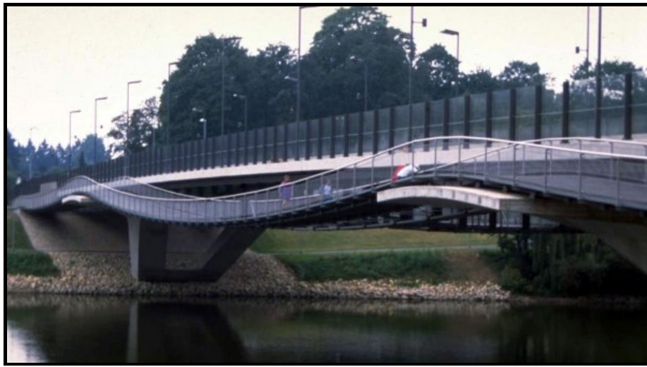
Figura I.17 – Em primeiro plano, Passarela Glacis apoiada em balanços dos pilares da ponte adjacente, em Ingolstadt, Alemanha (fonte; Structurae);
