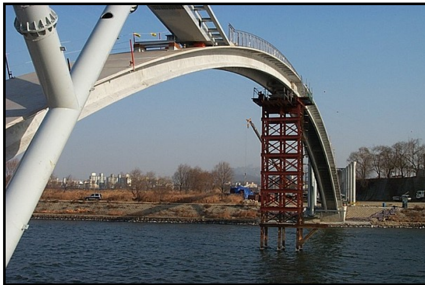
Figura I.26 – Perspectiva da Passarela Sun-Yu – fase construtiva, Coreia (Fonte; Structurae, fotógrafo: Alain Fournol).
